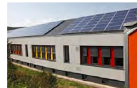
Sanierung auf Passivhausstandard
